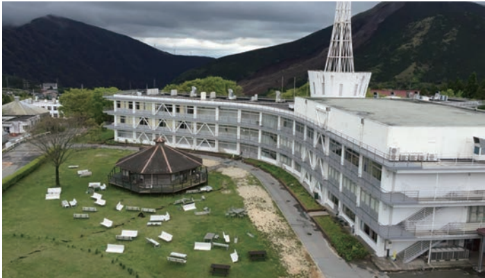
(写真2) 中央に亀裂が走る1号館前の中庭
