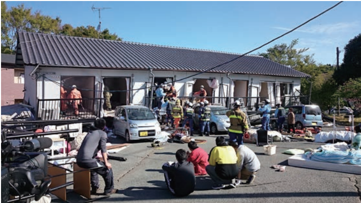
(写真1) 1階部分が押し潰されたアパートでの救出活動
