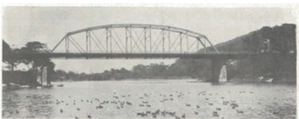
台北市にあった初代の明治橋 (画像提供:土木学会付属図書館)
