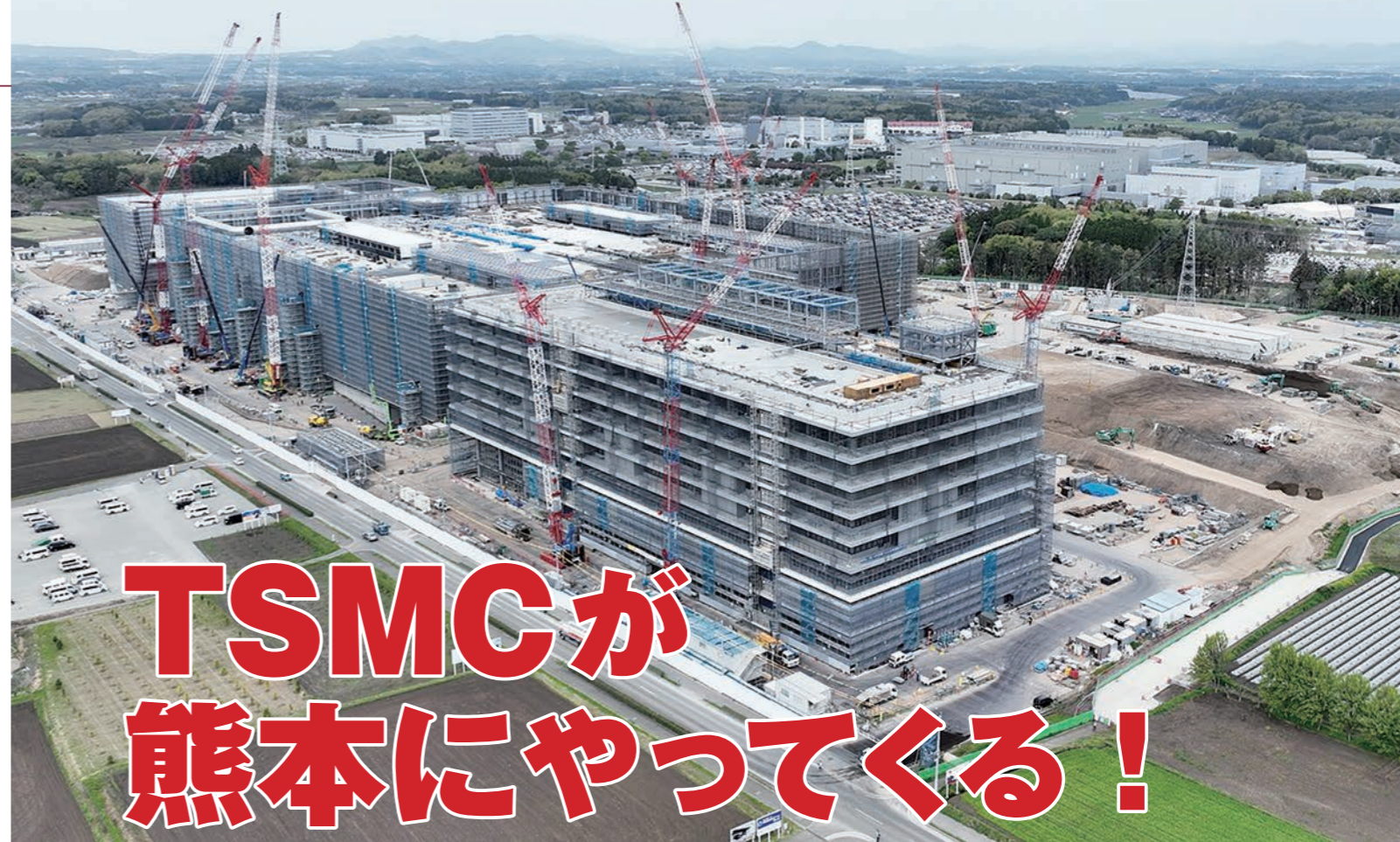
建設が進むTSMCの半導体工場＝2023年3月6日、菊陽町（熊本日日新聞社撮影）
